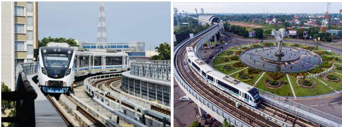
Gambar 6- 8 KA Perintis LRT Sumatera Selatan
