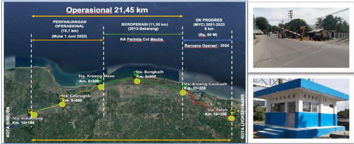
Gambar 4- 1 Pembangunan Jalur Kereta Api Lintas Lhokseumawe - Bireuen Segmen Krueng Geukueh – Paloh
