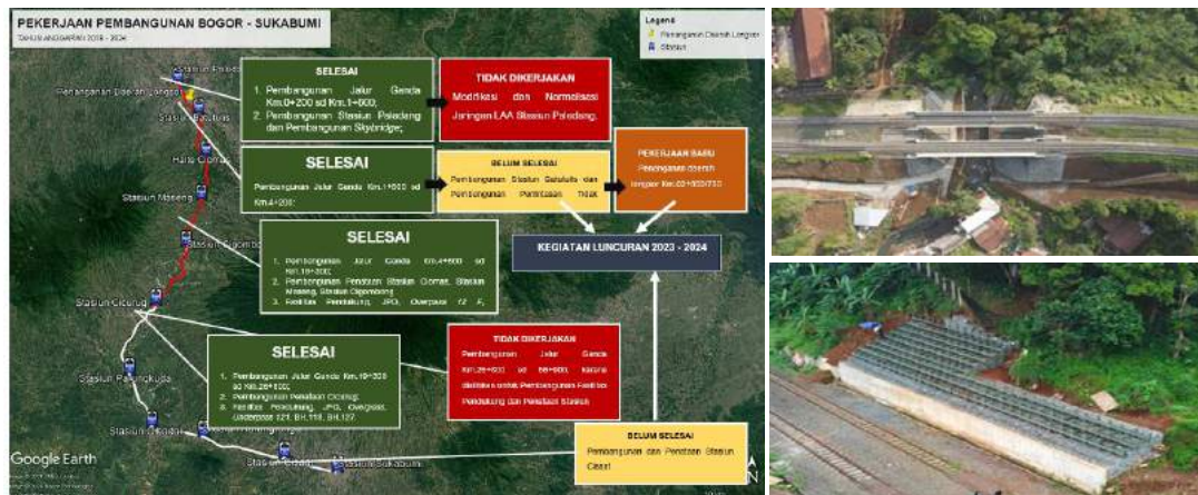
Gambar 4- 16 Progres Pembangunan Jalur Kereta Api Segmen Bogor – Sukabumi
