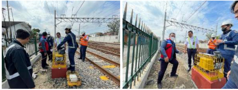
Gambar 4- 30 Pengukuran Pentanahan pada Axle Counter di Stasiun Solo Balapan
