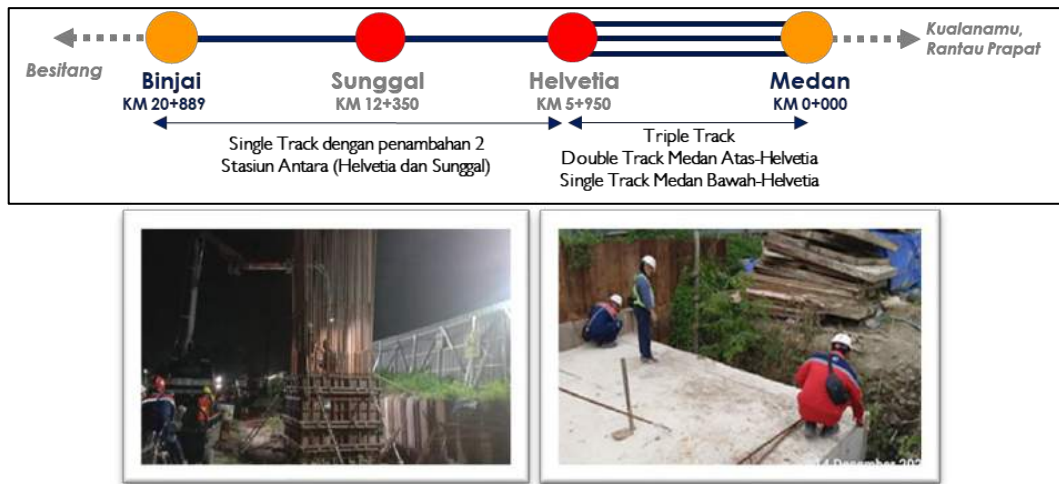
Gambar 4- 2 Progres Pembangunan Jalur Kereta Api Medan - Binjai
