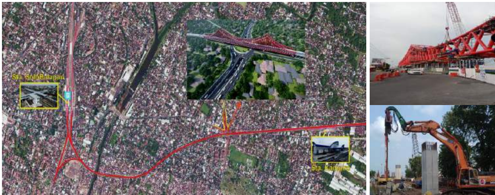
Gambar 4- 21 Progres Pembangunan jalur ganda kereta api Solo Balapan – Kalioso
