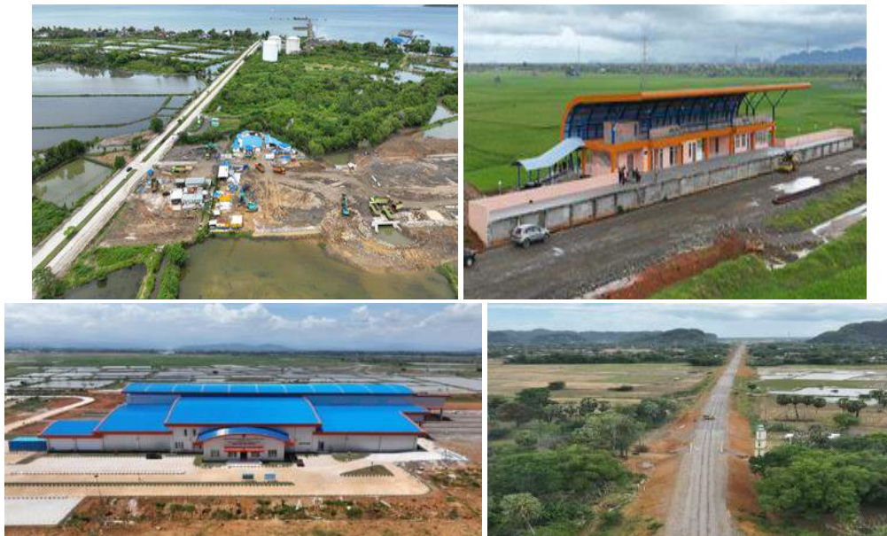
Gambar 4- 24 Hasil Pembangunan Jalur Kereta Api lintas Makassar - Parepare
