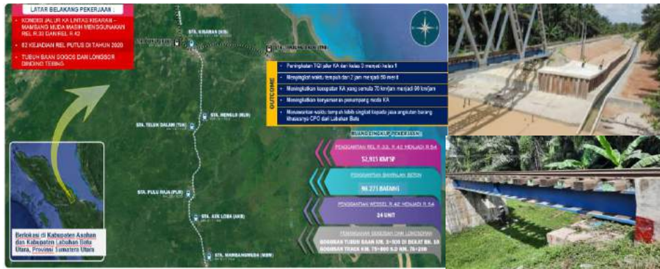
Gambar 4- 3 Progres Peningkatan Jalur Kereta Api Segmen Kisaran – Mambangmuda
