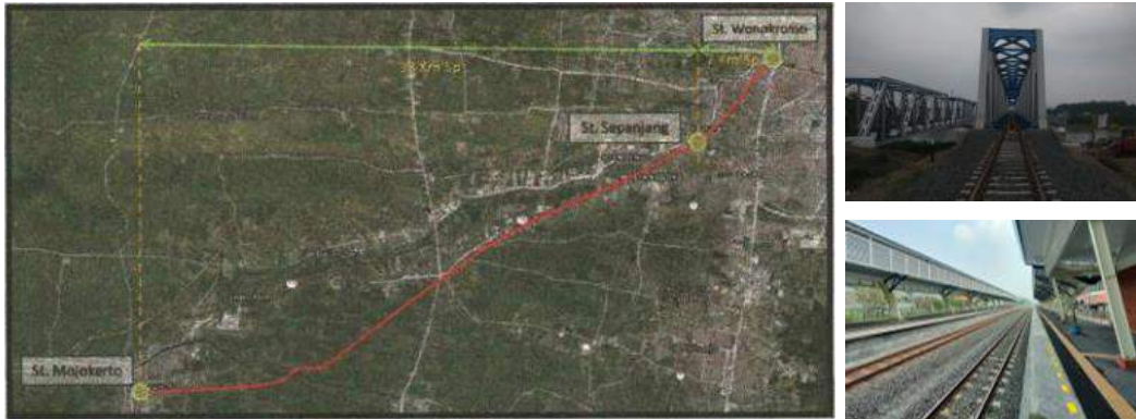
Gambar 4- 22 Progres Pembangunan Jalur Ganda Kereta Api lintas Mojokerto – Sepanjang
