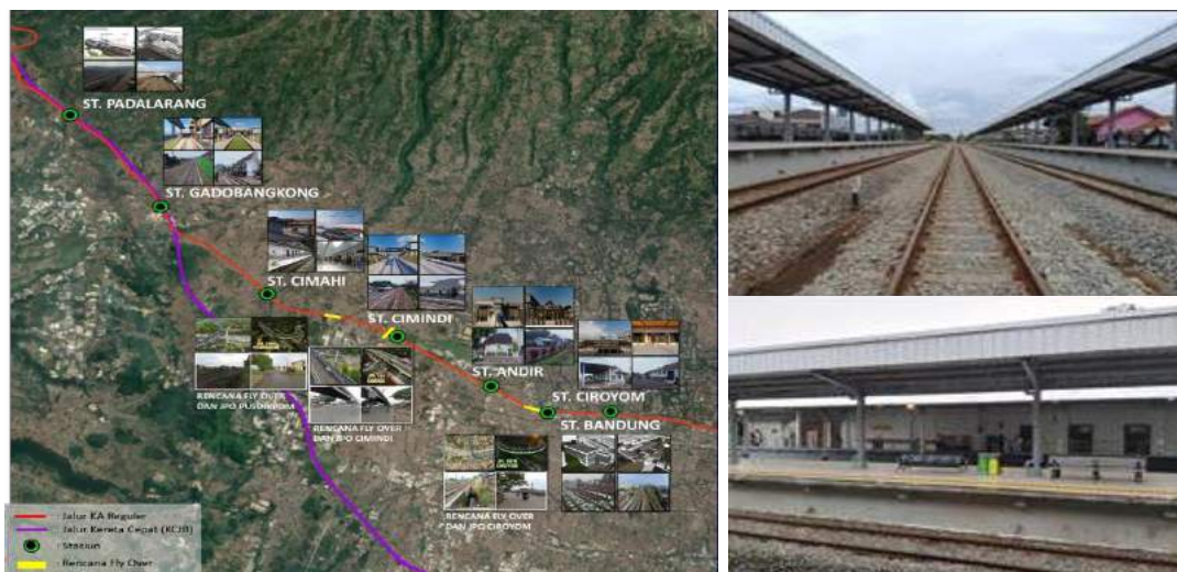
Gambar 4- 17 Progres Pembangunan Jalur Kereta Api Padalarang - Bandung
